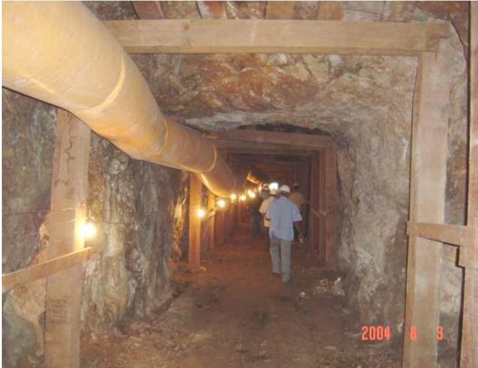
GALERIA NA JAZIDA
